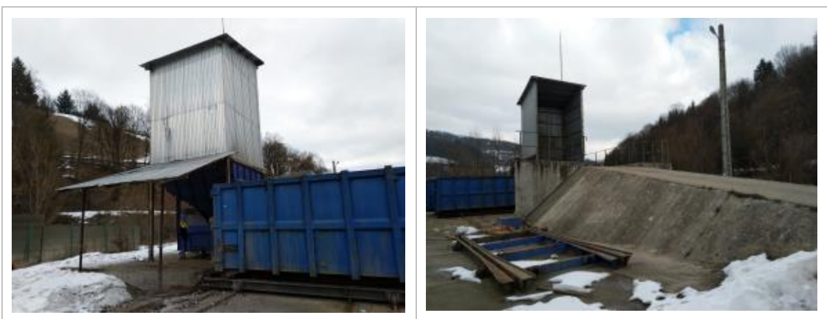
Figura 4 - 17: Stație de Transfer Abrud
